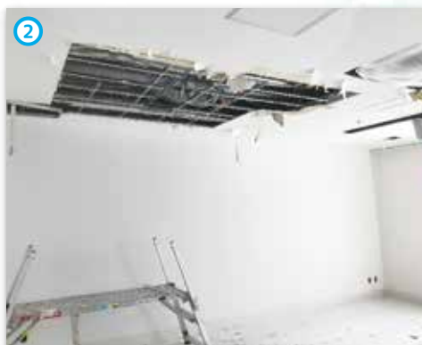
②天井解体
